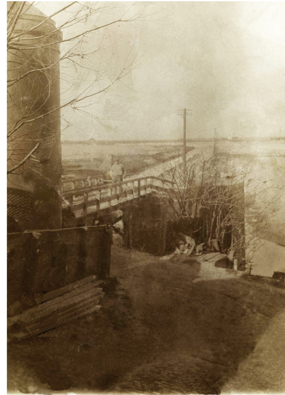
Zicht vanaf de boerderij op Nieuwendammerdijk 443 (met 'peperbus') richting de Zunderdorpergouw, met op de voorgrond de brug over de achtersloot (foto ca. 1910)
