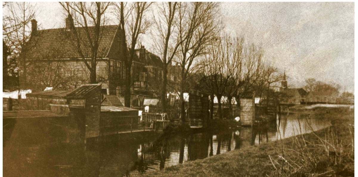
Achterzijde Nieuwendammerdijk (zicht vanaf het Klein Die naar Kerkepad)
